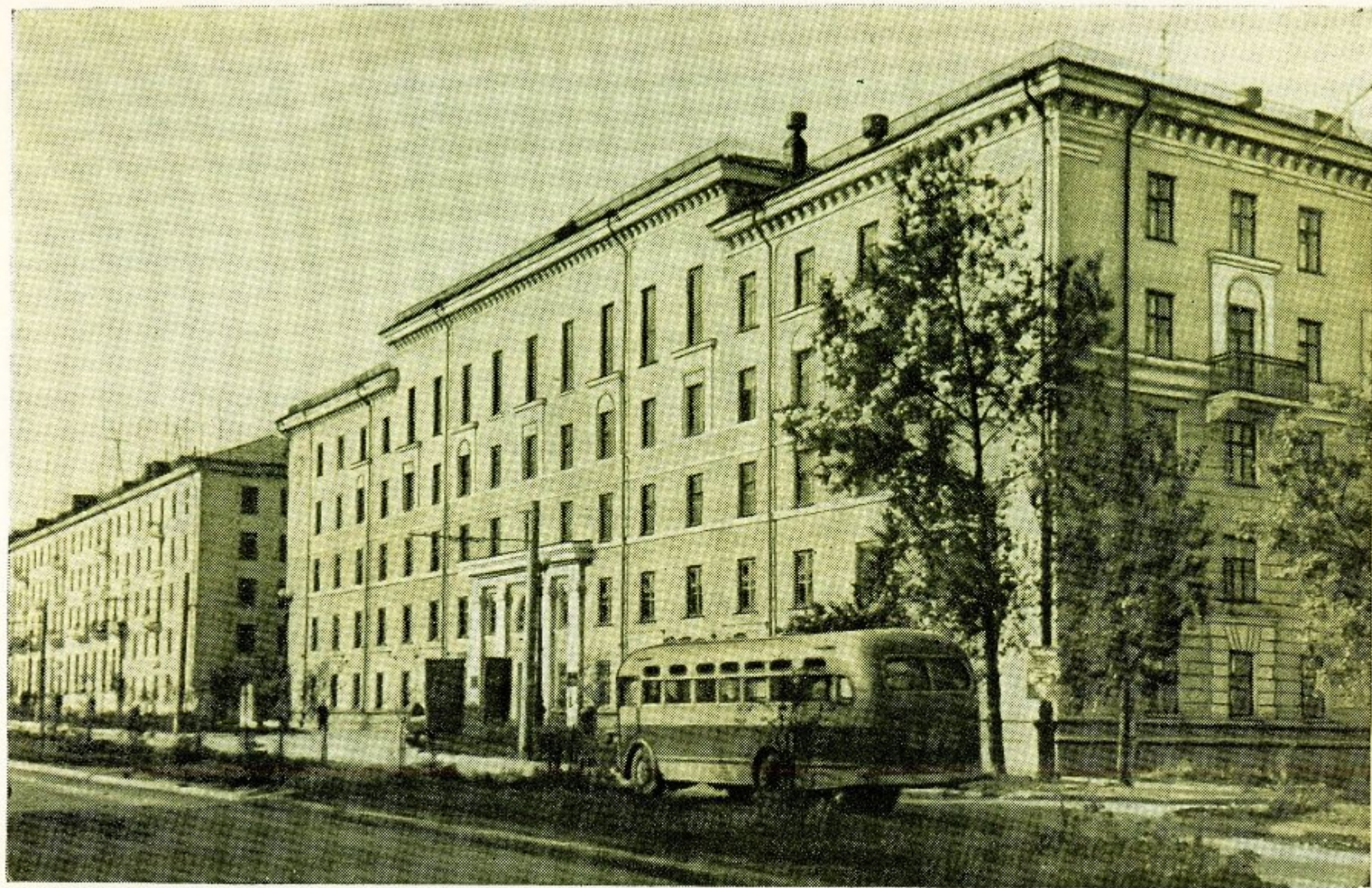
Здание строительного треста № 1.
